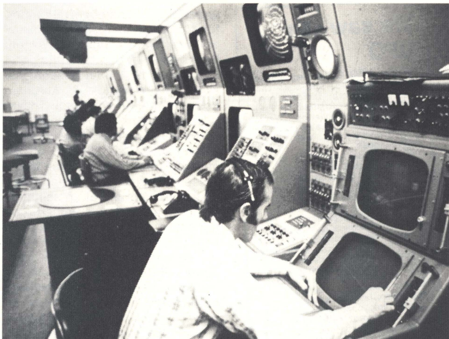
På dette ældre billede fra Toronto Center (Canada) ses forrest to GCA finale scoper (GCA = Ground Controlled Approach) af den type som også blev anvendt af Royal Air Force (RAF). På næste pult ses foroven et GCA search scope.
